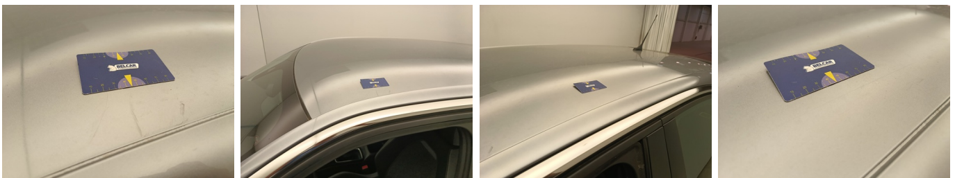
Boven - Dak - Kras - Spuiten
