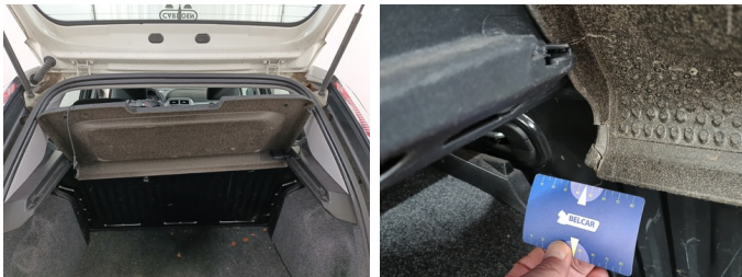
INT achteraan - Hoedenplank - Gebarsten - Vervangen
