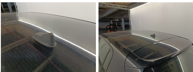
Boven - Antenne - Ontbreekt - Vervangen
