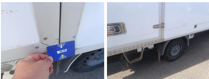
Deur RA - Deur RA - Kras - Vervangen
