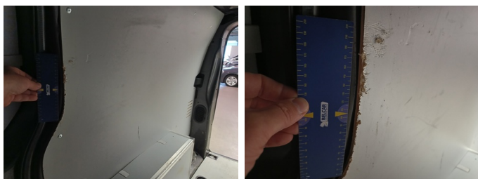
INT achteraan - Bekleding koffer R - Kras - Vervangen
